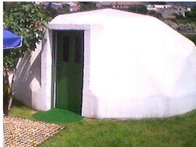
Od otpadne ambalaže-stiropora posebnim postupkom proizvodi se DRACOTERM za pripravu betona mase 350 kg/m<sup>3</sup>. Ovaj ima izvrsna toplinska svojstva, lako se ugrađuje i obrađuje. Od DRACOTERM-BETONA proizvode se elementi za malu montažnu kućicu samonosive konstrukcije - (geodetska kupola prof. Fullera).
