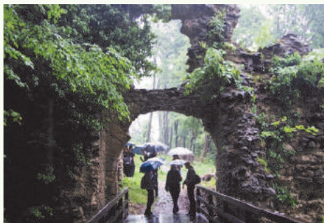
Garićgrad, glavni ulaz
