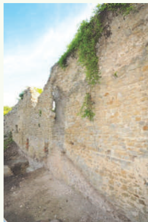
Sjeverni zid sa stubama
