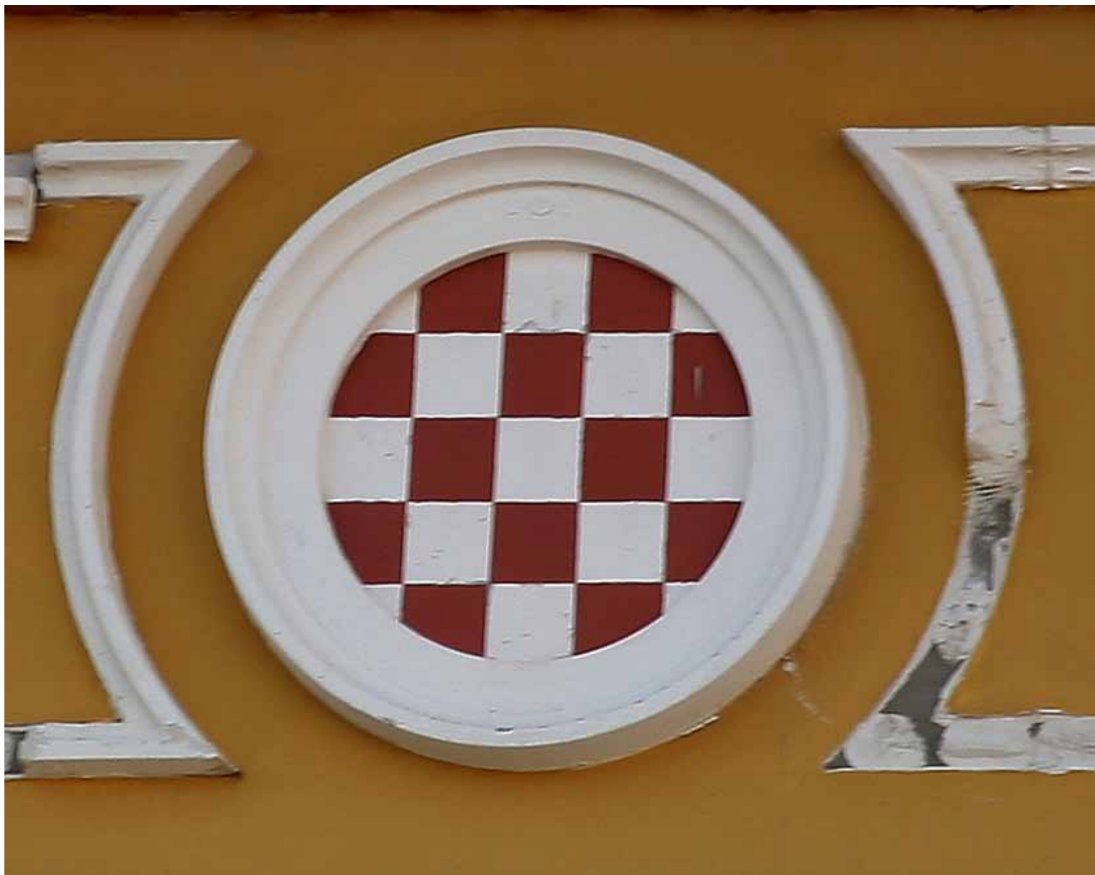
8. Povijesni hrvatski grb na pročelju „Vile San“, Garina 15 Bojana žbuka, promjer oko 40 cm / Povijesni hrvatski grb / Početak XXI. st. Historical Croatian coat of arms on the façade of “Villa San”, Garina 15 Painted plaster, around 40 cm in diameter / Historical Croatian coat of arms / Beginning of the 21st century Stemma storico croato sulla facciata della “Villa San” in via Garina 15 Intonaco colorato, diametro circa 40 cm. / Stemma storico croato. / Inizio del duemila. (photo: D. Krizmanić)
